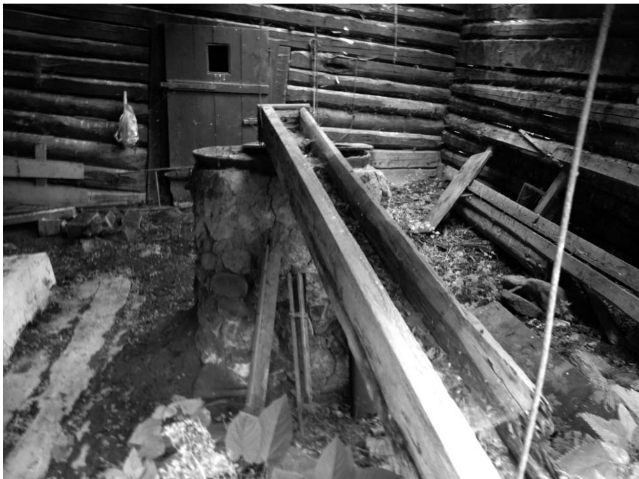
5. kép. A vízmelegítő katlan. (BARDÓCZ-TÓDOR Enikő felvétele, 1994)
